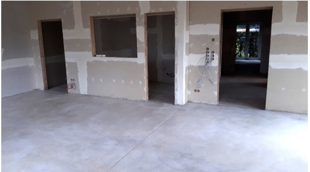
15.07.2022 Der Innenausbau wird fortgesetzt
