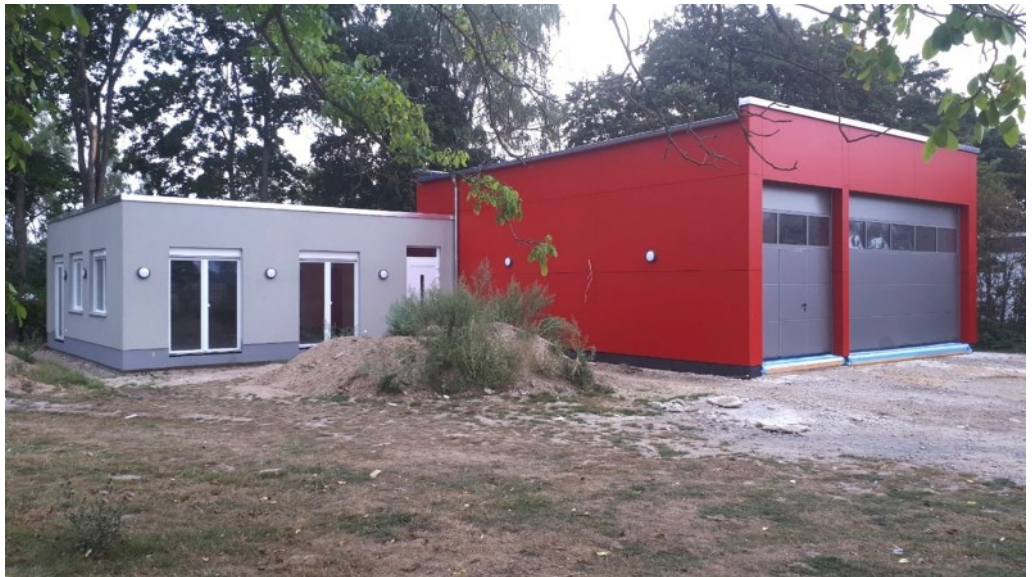
07.08.2022 Die Aussenfassade des AEZ ist weitestgehend hergestellt
