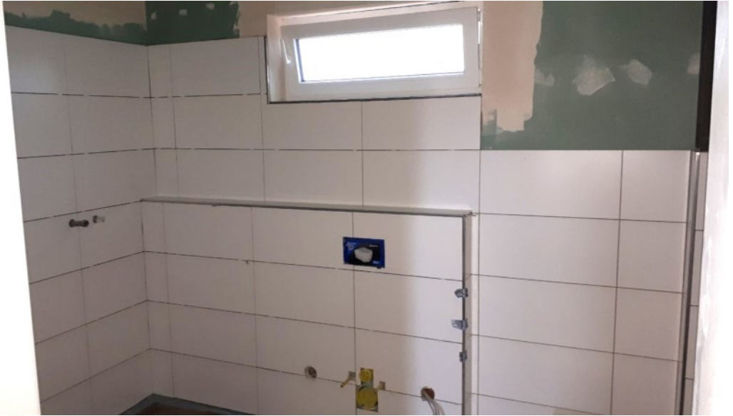
18.08.2022 Die WC-Räume erhalten ihre Fliesen
