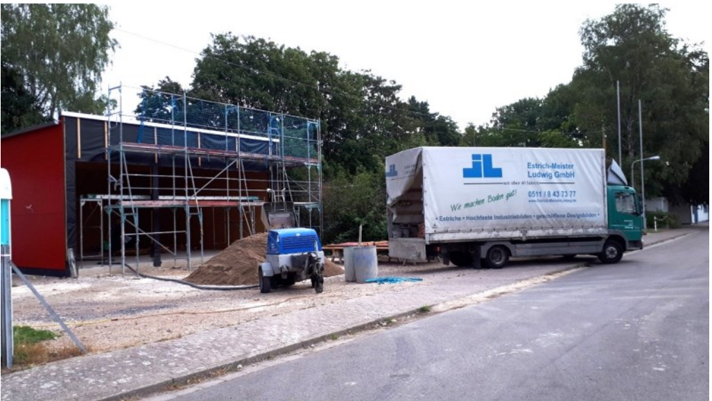
11.07.2022 Das AEZ bekommt seinen Estrichfußboden
