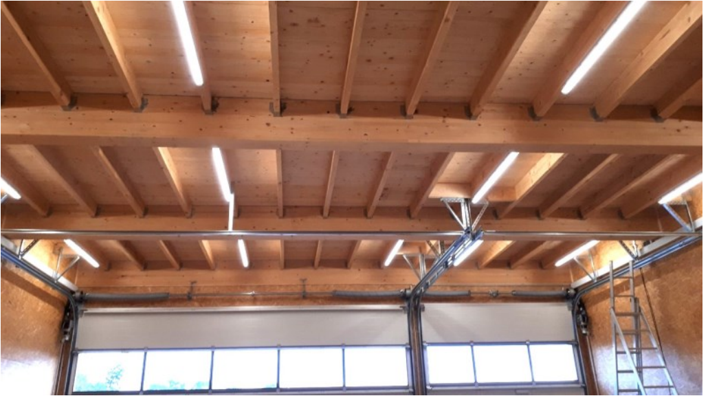
28.09.2022 Die Deckenbeleuchtung in der Mehrzweckhalle des AEZ besteht ihren ersten Test
