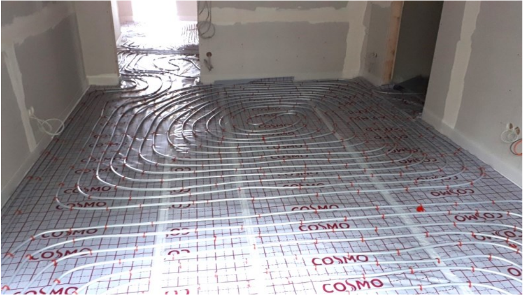
01.07.2022 Die Fußbodenheizung wird im AEZ verlegt
