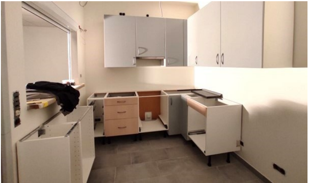
01.10.2022 Die ersten Küchenmöbel wurden in der Küche des AEZ eingebaut
