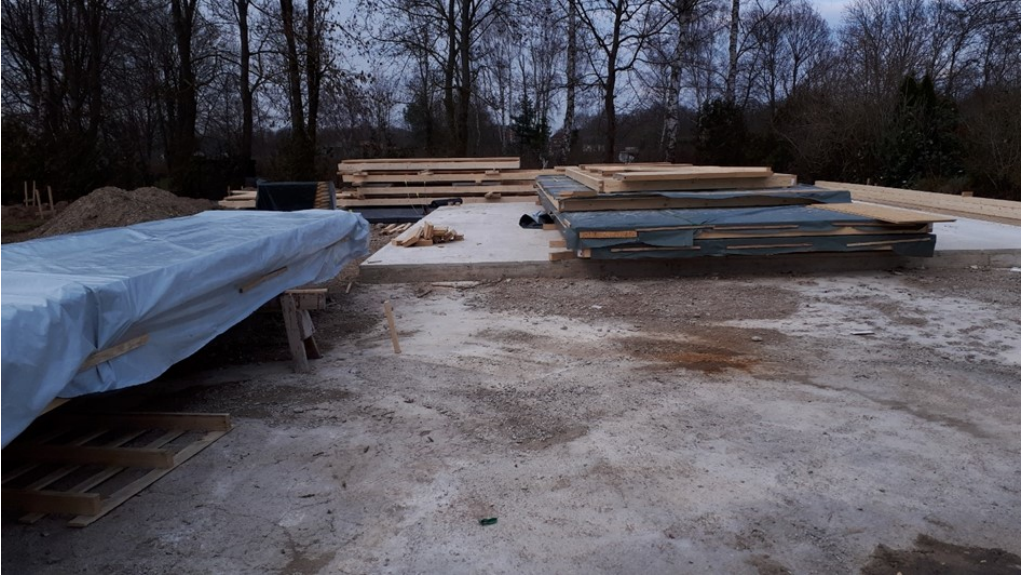
15.02.2022 Die Außenwände sind vorgefertigt.
