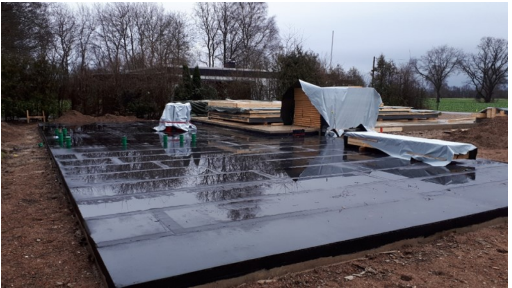
10.02.2022 Die Isolierung der Bodenplatte ist hergestellt und der Wand-aufbau beginnt.
