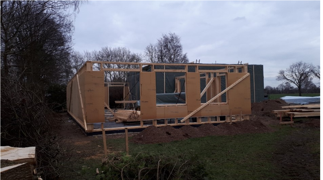
22.02.2022 Die Außenwände sind aufgestellt.
