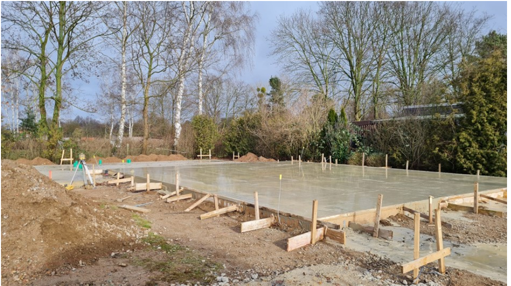
31.01.2022 Die Bodenplatte ist fertig
