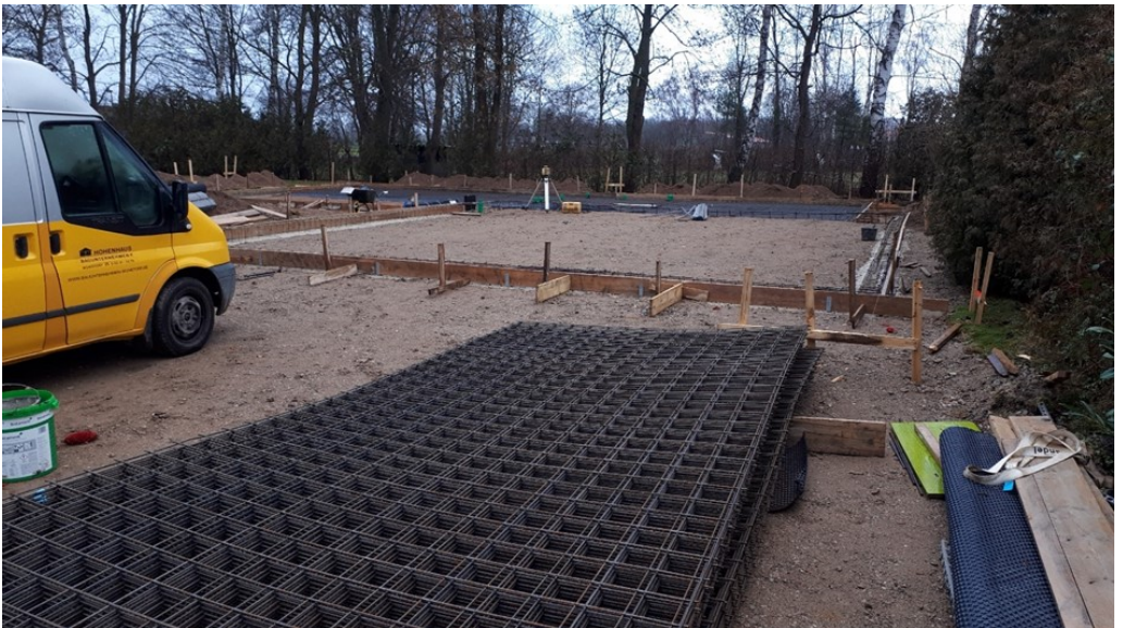
17.01.2022 die Vorbereitungen für die Bodenplatte laufen
